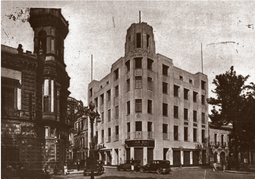
Edificio "La Nacional", estuvo ubicado en una esquina de las calles Prisciliano Sánchez y 16 de septiembre.
