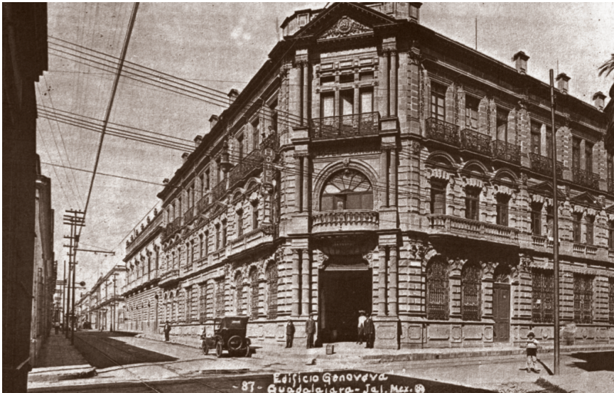
El edificio "Geneveva".
